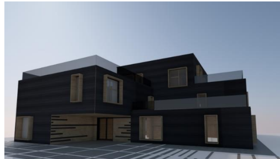
Új közösségi ház épülete
